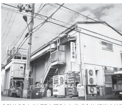
合計約20本のLEDを導入した株式会社 清光の外観。
