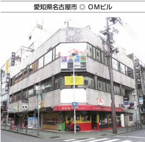
愛知県名古屋市◎OMビル
