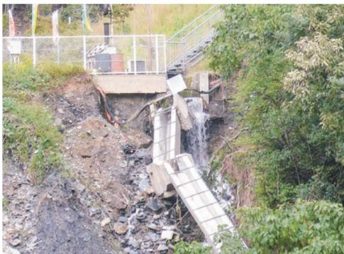
土砂が斜面を崩れ、埋設されたケーブルが露出する被害があった。
