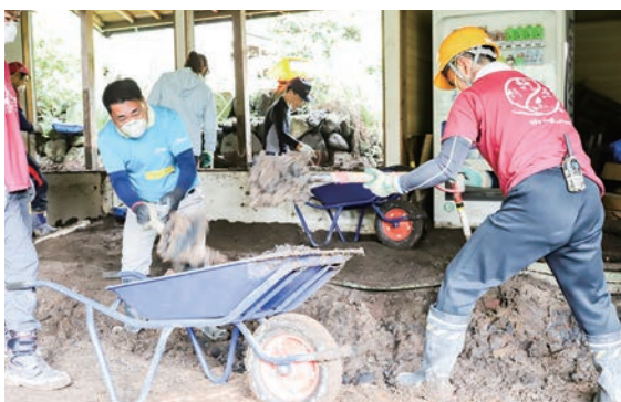
プロジェクトに賛同した約3000人のボランティアが懸命に作業。
