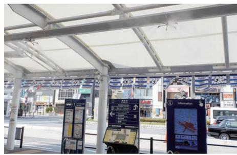
熊谷駅前広場に設置された冷却ミスト・クールビズ期間に合わせて稼働する。センサーで気象条件を感知して自動運転している。
