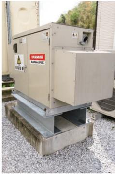
交換後の非常用発電機。浸水対策のため鉄骨で約30cmかさ上げしている。
