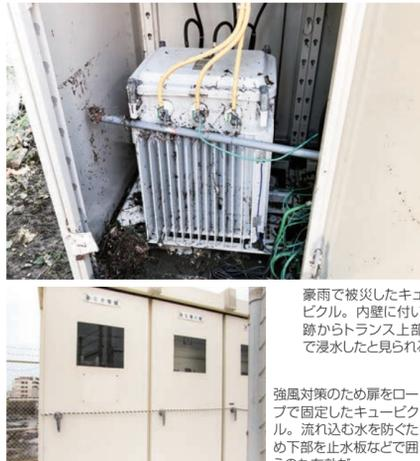
豪雨で被災したキュービクル。内壁に付いた跡からトランス上部まで浸水したと見られる。
